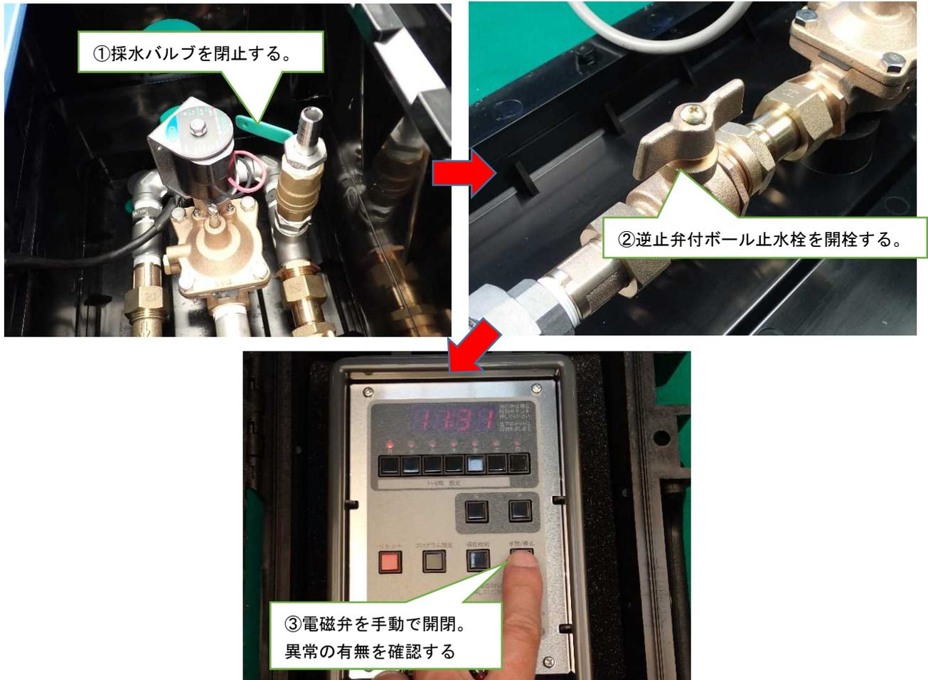
13) コントローラの現在時刻および排水条件が正しく設定されているかを確認し、コントローラボックスを閉め、元通りに復旧してください。
