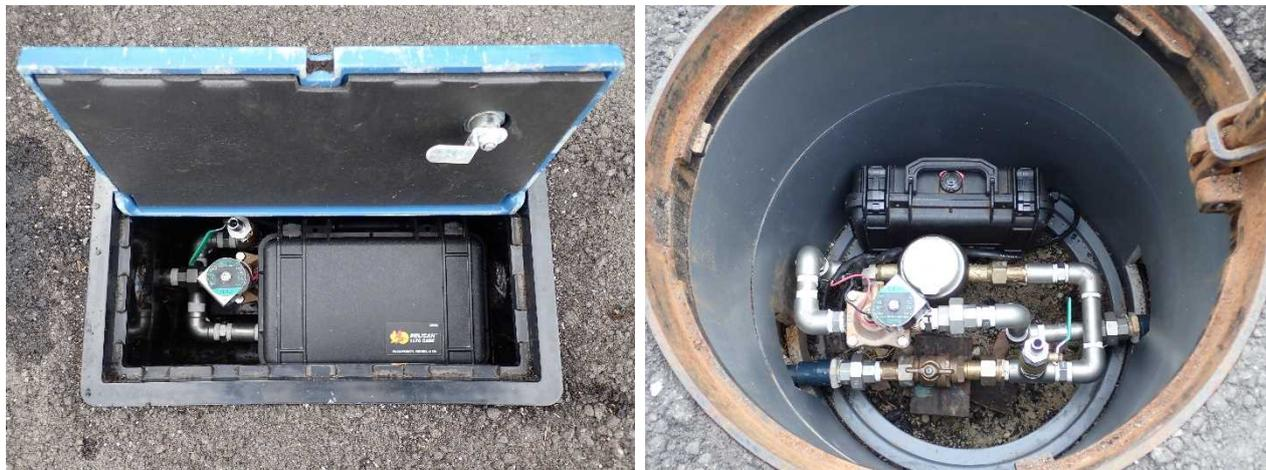
⚠️ コントローラボックスを閉じる前は必ず、ケーブルグラウンドの確認と O リングおよび受枠の清掃 (P23、3.7 項参照) を行ってください。正しく行わない場合、IP67 の防水性が損なわれる恐れがあります。
