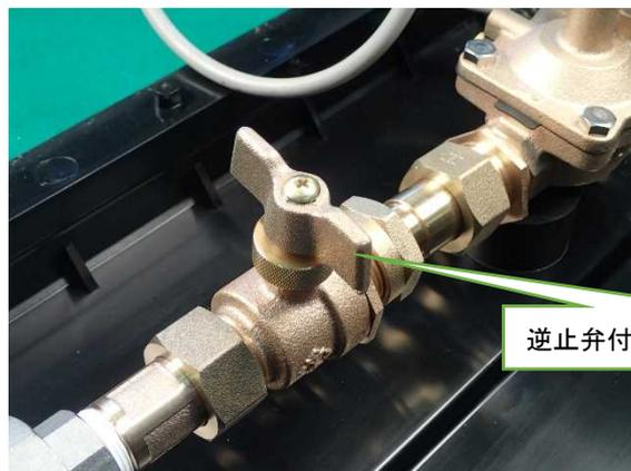
逆止弁付ボール止水栓を閉止する。
