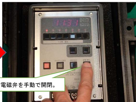
電磁弁を手動で開閉。
