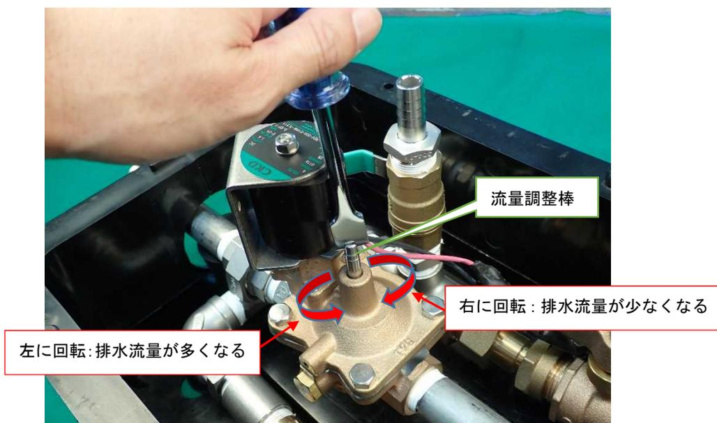
**⚠** 流量調整棒を目一杯まで右に回すと、排水が完全に止まります。故障と間違わないよう、ご注意ください。
